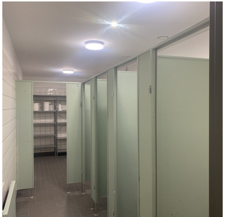
Der neue Anstrich für die Toiletten.
